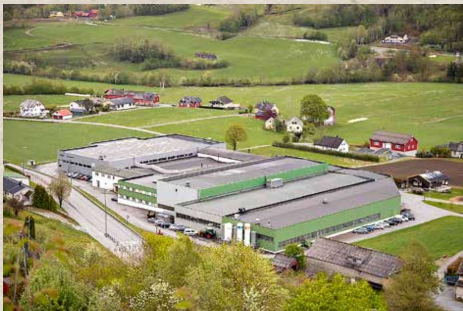
Industrieventyret: Lids fabrikk i Steinsdalen har mer enn 11 000 kvadratmeter under tak.
